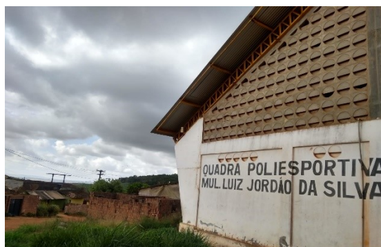
Imagem 17: Prédio da escola em reforma interna. Fonte: A autora.
