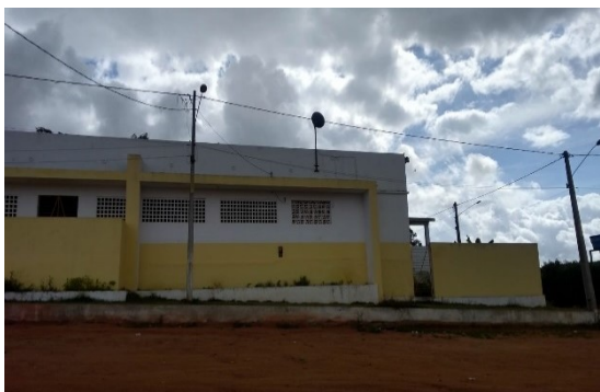
Imagem 16: Prédio da escola em reforma interna. Fonte: A autora.
